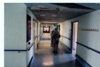
Gang voor de renovatie
